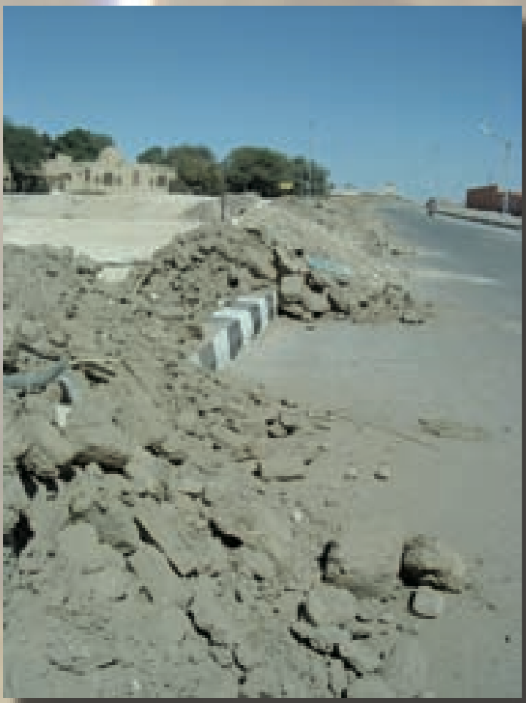
Dumps of debris from demolished houses. Décharge de débris provenant des maisons démolies.
