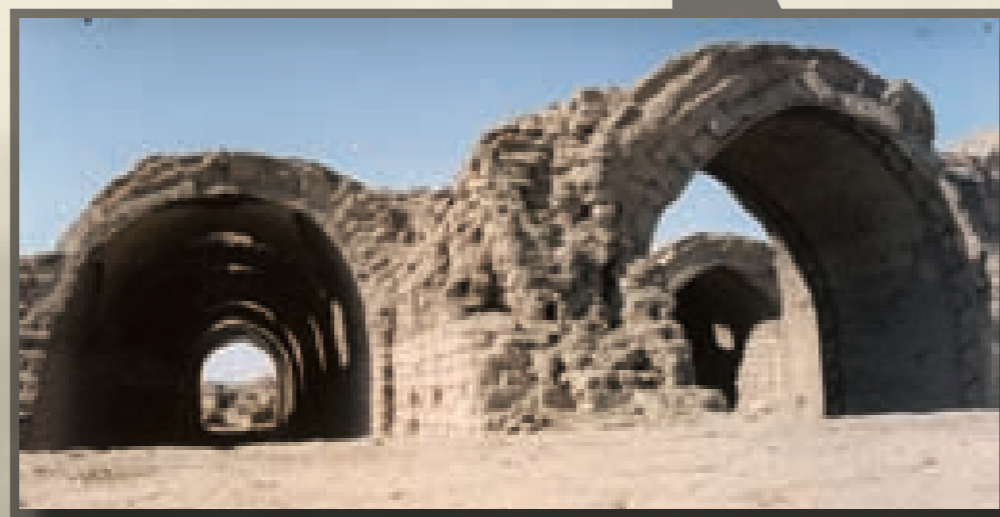
The Ramesseum granary vaults, 12th century BC Les voûtes des greniers de Ramesseum, 12ème siècle avant JC
