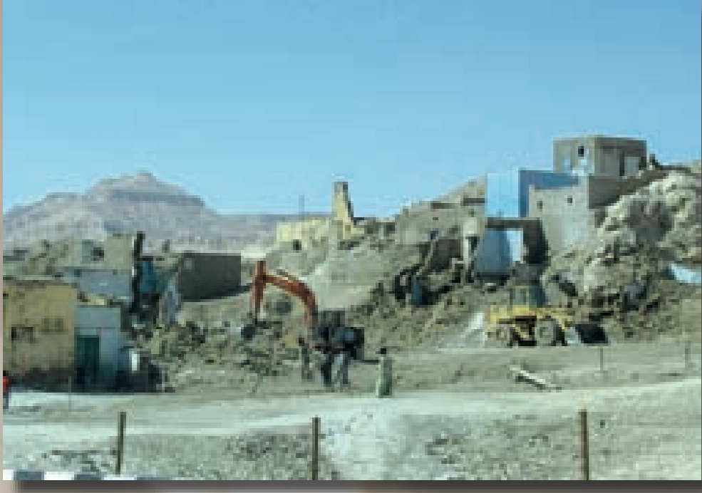
Demolition work December 2006 – March 2007 Travaux de démolition, décembre 2006 – mars 2007
