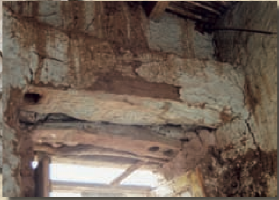
Coptic weavers' house, window detail showing re-used timbers Maison de tisserand copte, détail de fenêtre montrant le bois réutilisé
