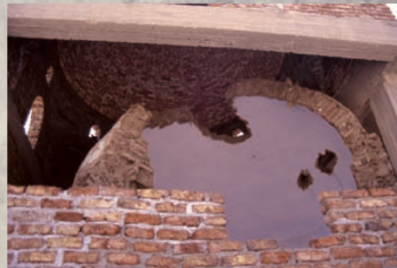
20th century shrine of Sheikh abu el-Qumsan, mud-brick dome being replaced with fired brick, 1997. Tombeau de Sheikh abu el-Qumsan 20ème siècle, dôme en briques de boue étant remplacées par des briques chauffées, 1997.
